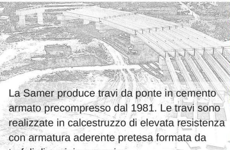
La Samer produce travi da ponte in cemento armato precompresso dal 1981. Le travi sono realizzate in calcestruzzo di elevata resistenza con armatura aderente pretesa formata da trefoli di acciaio armonico.
